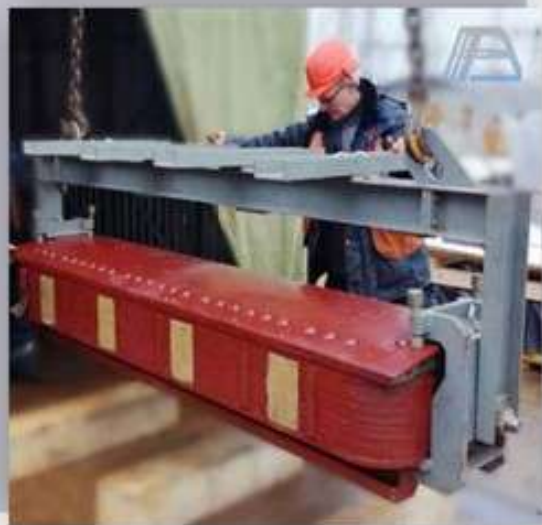
Капитальный ремонт полюсов КСВБ-160
