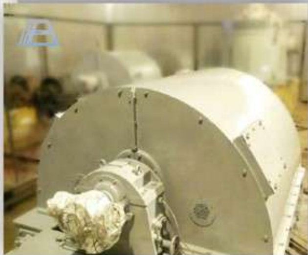
Капитальный ремонт STD-1600-2, 1600 кВт
