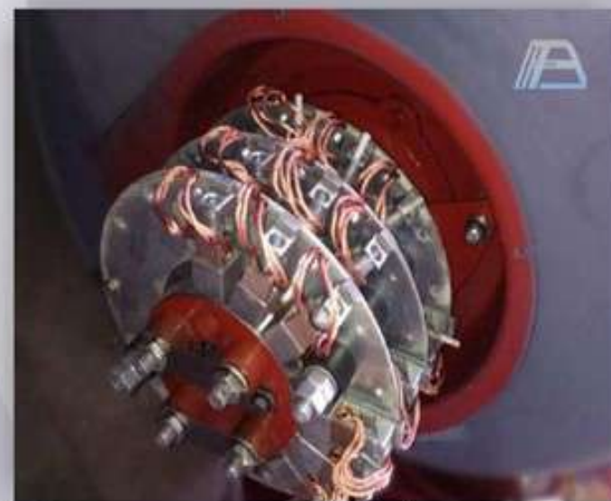
Капитальный ремонт АК-500-10-750УХЛ, 500 кВт
