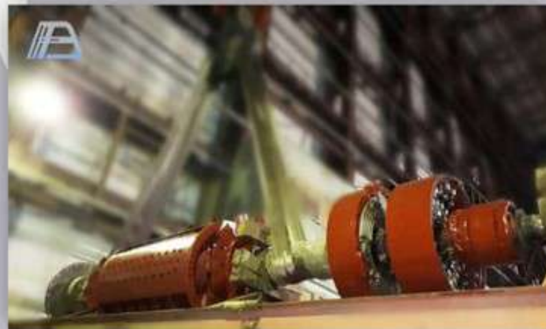
Капитальный ремонт ротора TABL – RCCPY, 18200 кВт, 10 кВ
