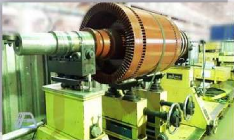
Капитальный ремонт ротора DSRAJ-6323-6WF, 1600 кВт
