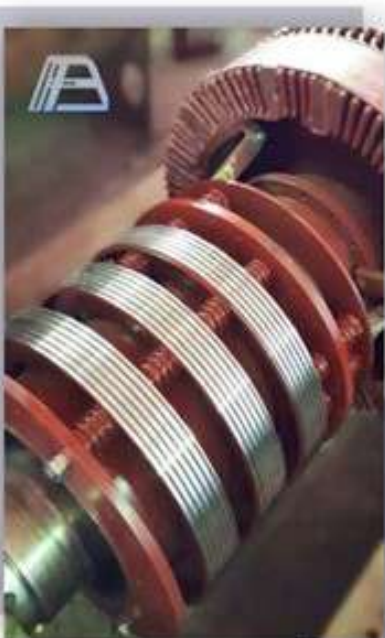
Замена корпусной и витковой изоляции катушек ротора электродвигателя TABL – RCCPY
