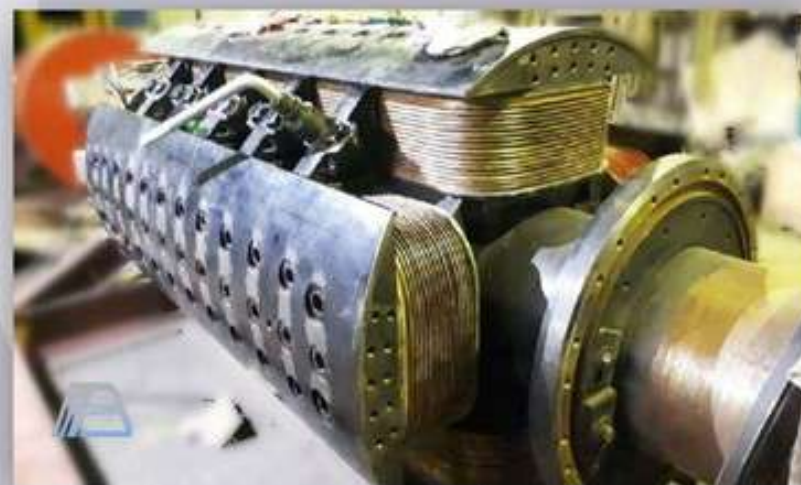
Замена корпусной и витковой изоляции катушек ротора TABL – RCCPY
